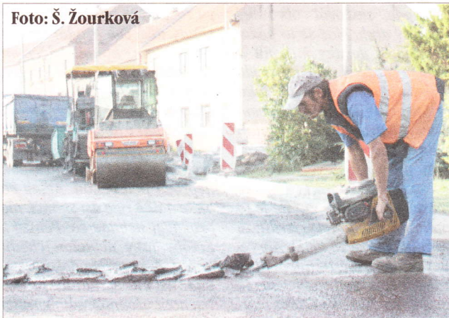
Bařice už si novou silnici i zastávky opravdu zaslouhaly.
